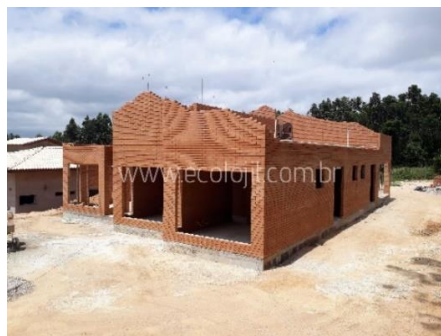
Figura 5: Aplicação do tijolo ecológico Fonte: EcolojiT (2024)
