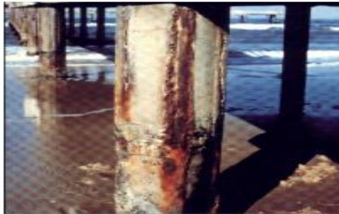
Figura 1: Estaca de concreto armado com manchas de corrosão Fonte: ABRACO RP –CAC – 001 (2019)
