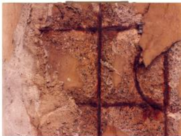
Figura 2: Lajes de concreto armado com armadura exposta com intensa corrosão em área de concreto deslocado
