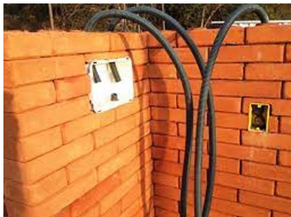
Figura 4: Tubulação Elétrica passando pelo tijolo ecológico Fonte: Trindade Tijolos ecológicos (2013)
