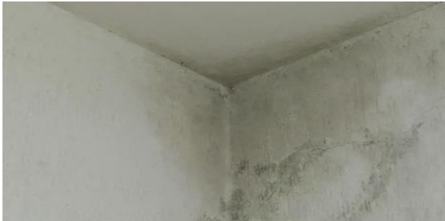
Figura 2. Infiltração provocada por capilaridade.
