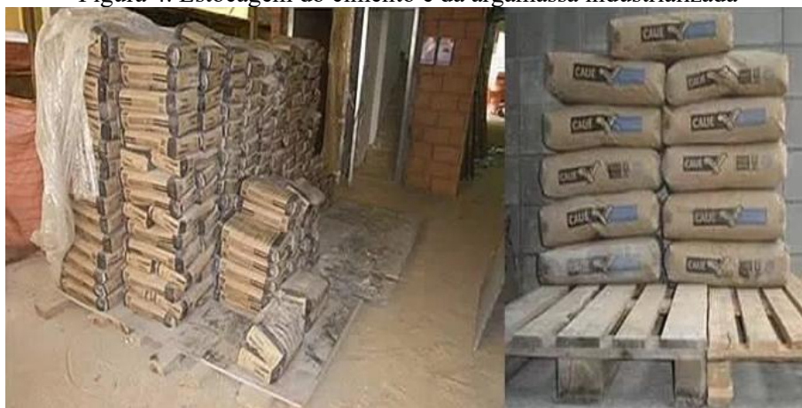
Figura 4. Estocagem do cimento e da argamassa industrializada
