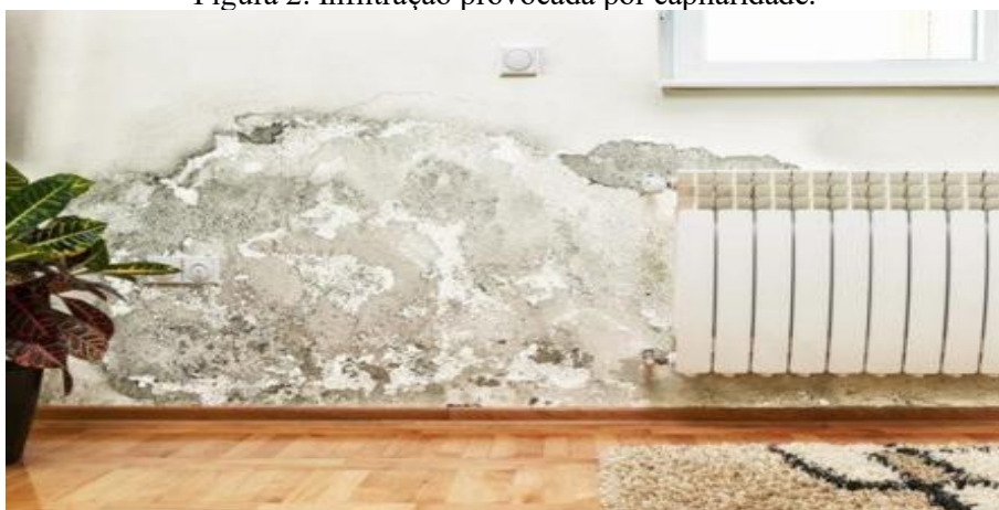
Figura 2. Infiltração provocada por capilaridade.
