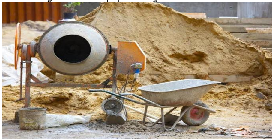
Figura 1. Local de preparo da argamassa com betoneira.
