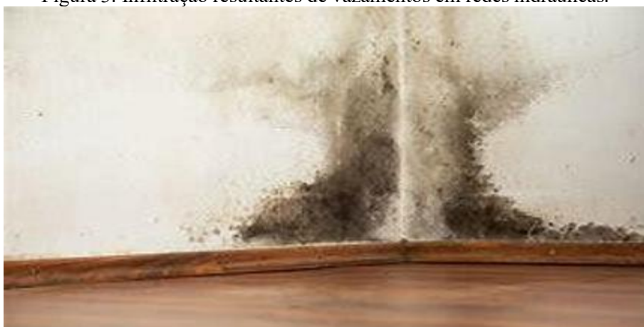
Figura 3. Infiltração resultantes de vazamentos em redes hidráulicas.
