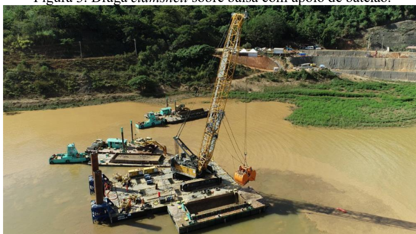
Figura 3. Draga clamshell sobre balsa com apoio de batelão.
