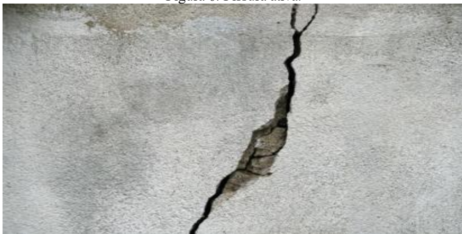
Figura 6. Fissura ativa.
