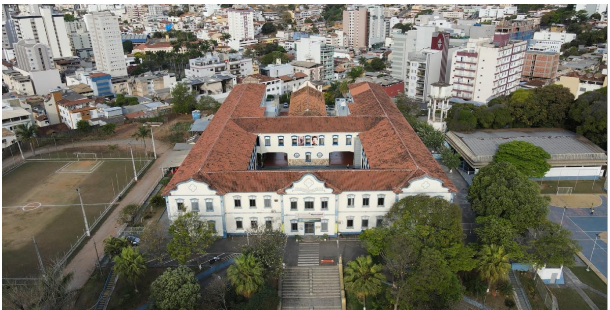
Frente do prédio – entrada principal
